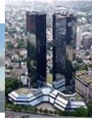
Deutsche Bank Twin Towers
